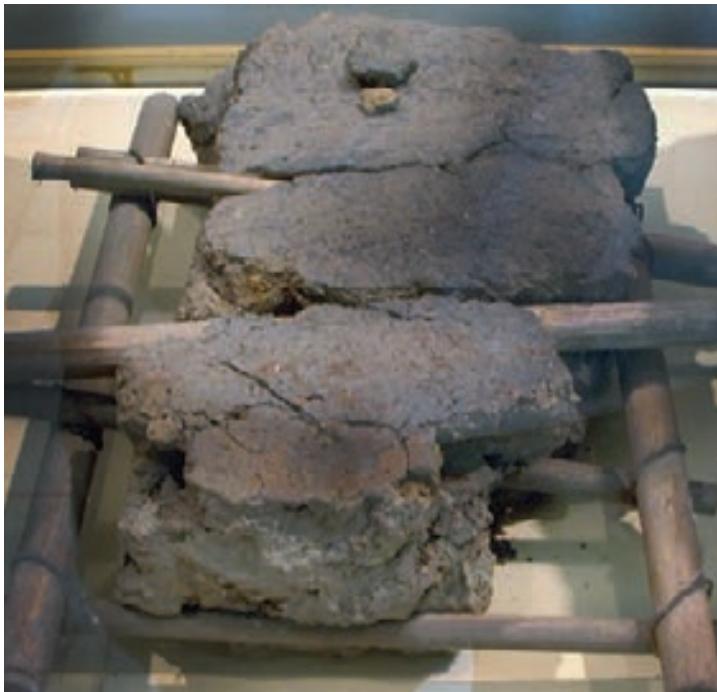
79 Detalle de bajareque, sistema constructivo utilizado en las paredes de las casas de Joya de Cerén.
