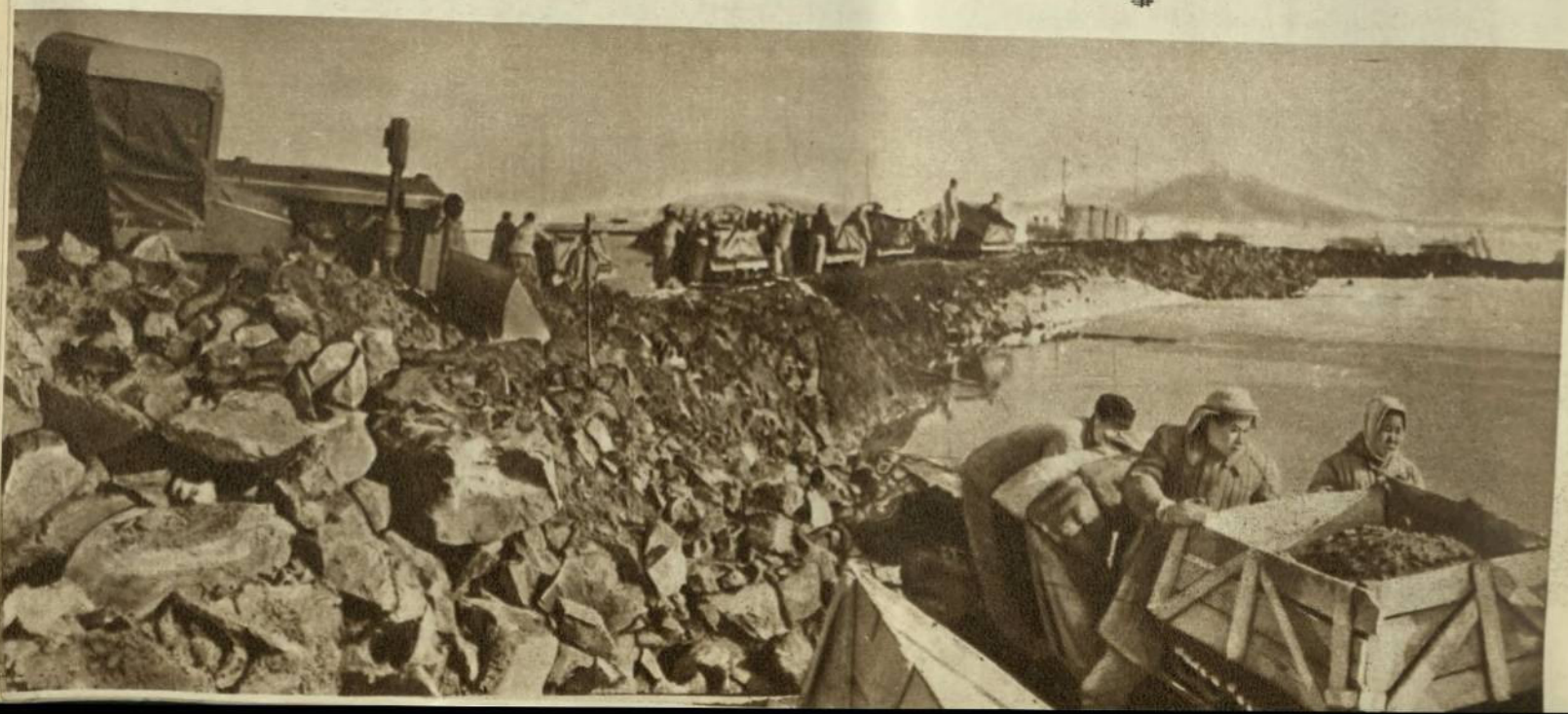
Перекрытие русла реки Рёнхынган для защиты 350 гектаров посевной площади от затопления. The embankment works of the Ryongheung River which will protect 350 hectares of land
