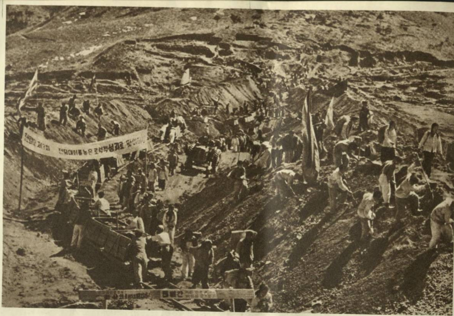
Строительство магистрального канала № 1 и вид канала по окончании строительства. Trunk canal No. 1 in the Uhro field under construction and the view of the canal completed
