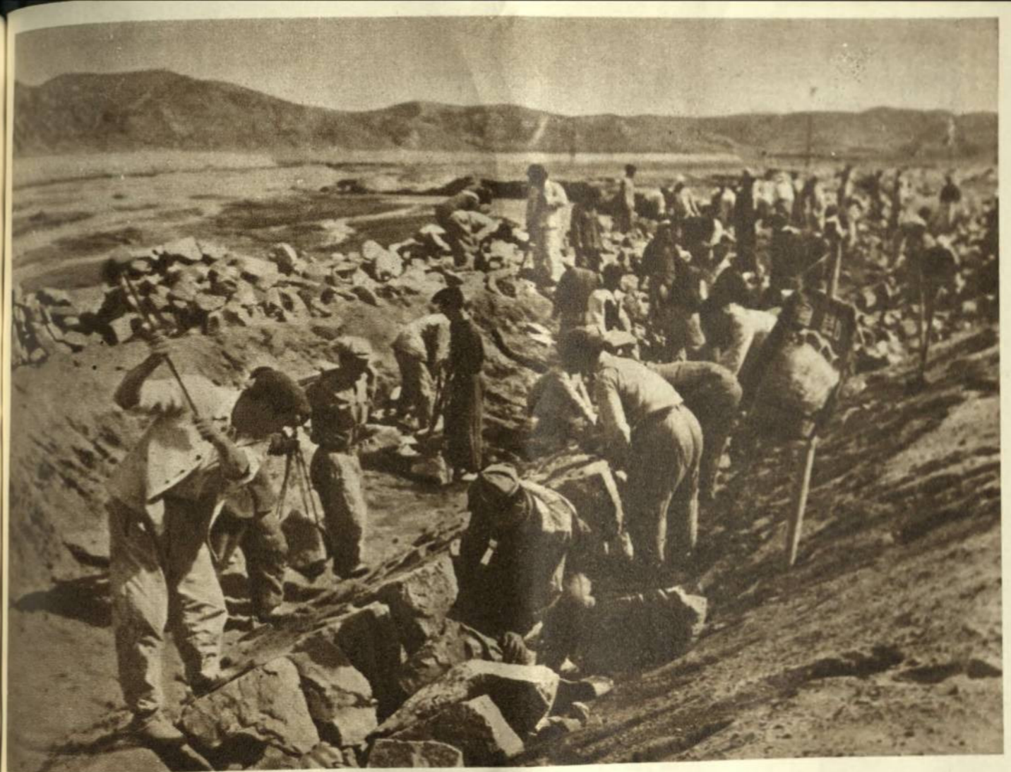
Строительство дамбы на реке Оранчен в провинции Северный Хамген. Внизу — Шлюзы на канале у реки Оранчен
