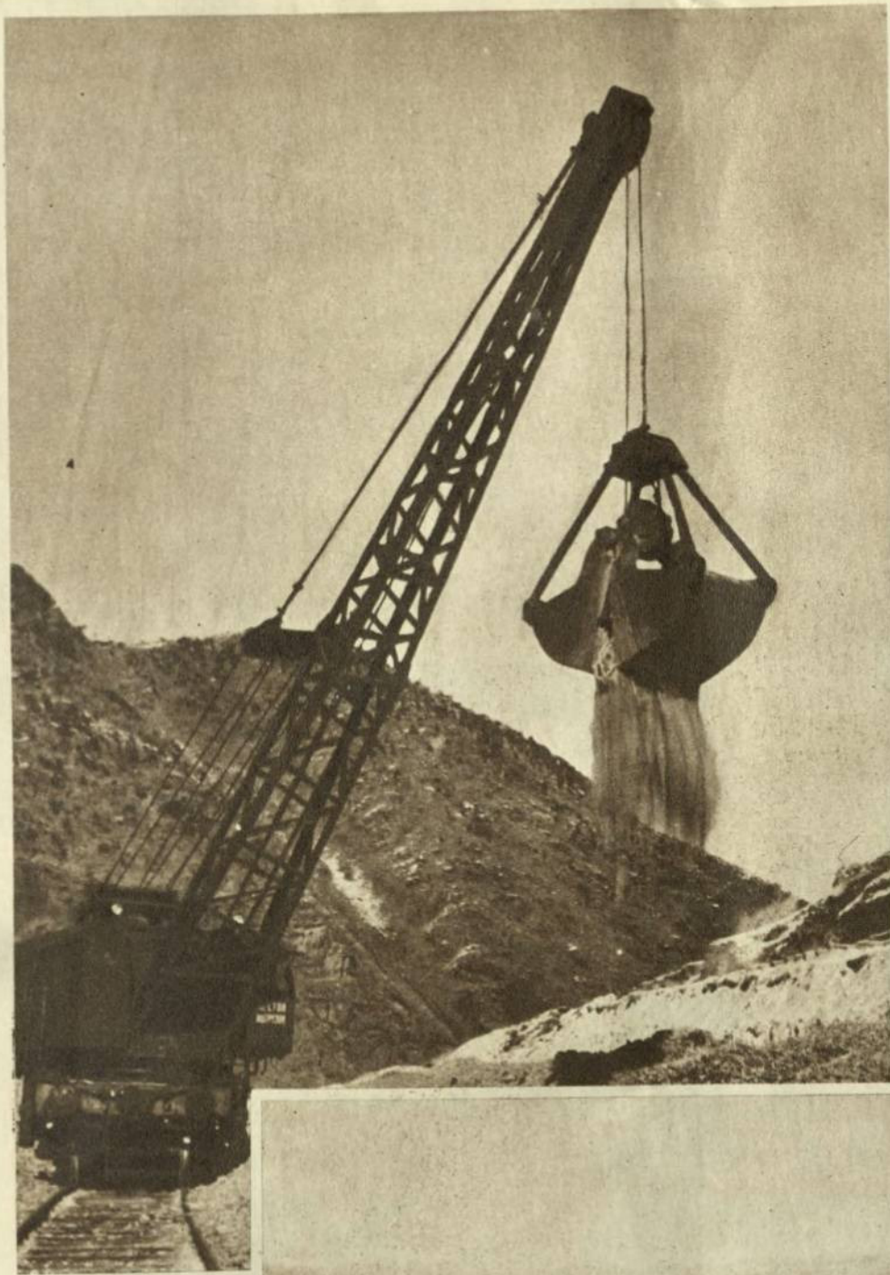
На стройках широко использовались новейшие строительные машины, присланные народами братских стран. На снимках: Советские экскаватор и бульдозер.
