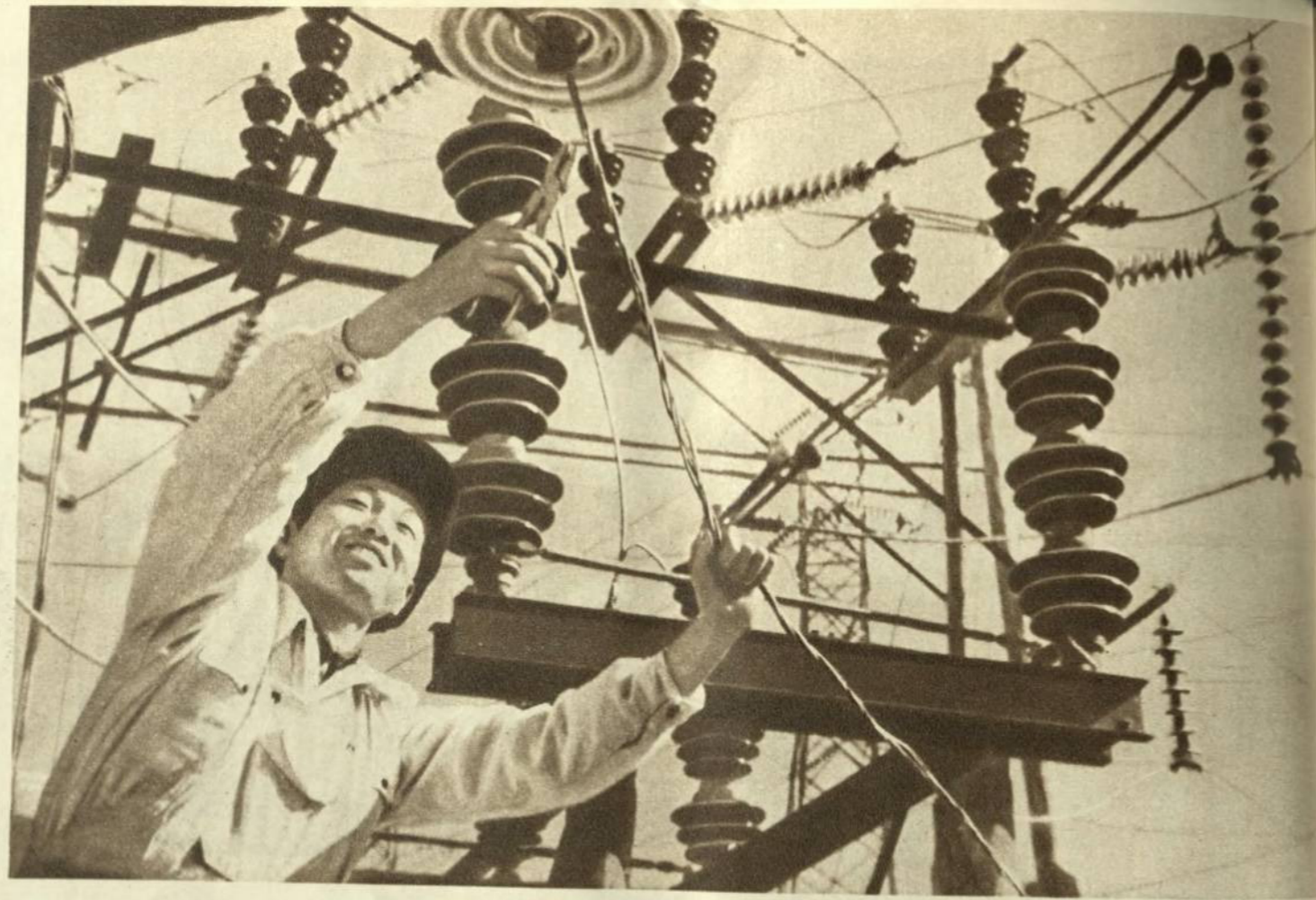
Промышленность Республики оказала огромную помощь строительству ирригационных сооружений. Вверху: Монтаж электрической подстанции. Внизу: Канавокопатели нового типа перед отправкой на стройки. Industry of the Republic rendered great help to the construction of irrigation facilities. Above: Building of an electric sub-station. Below: New type ditch excavators ready to be sent to construction sites
