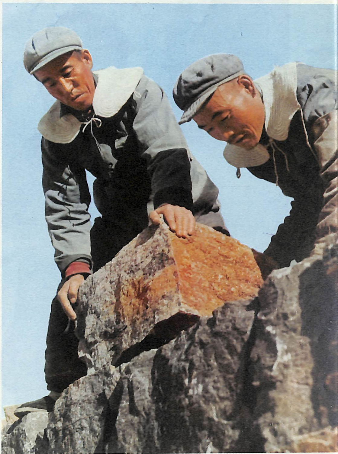
大寨公社南墙大队党支部书记李锁寿（左）正在砌石坝造田。
