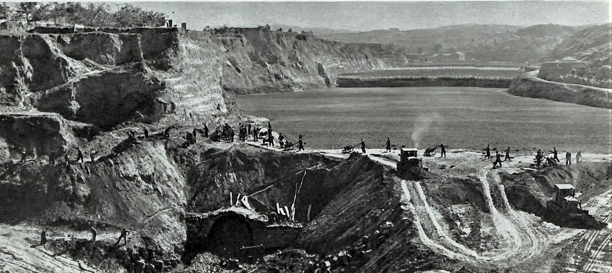
李家庄公社石坪大队在山沟里造涵洞，洞中走水，洞上造田。已造涵洞达七千二百多米，洞上造田五百多亩。
