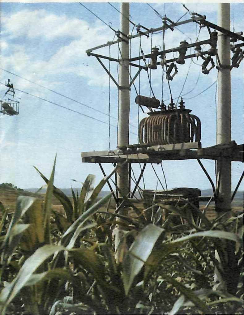
架设电力高空索道，改善了农业运输条件。
