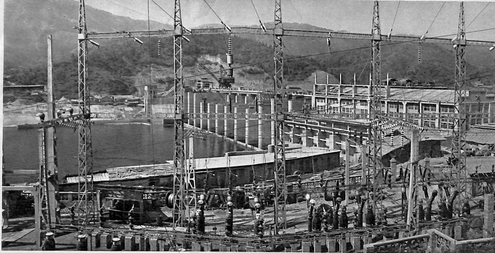
国家在融江上修建的麻石水电站。
